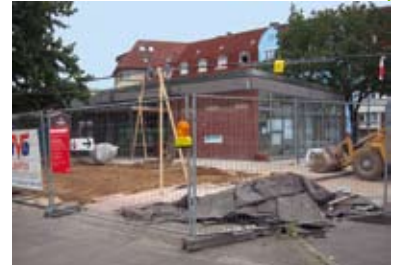
Umbau der Sparkasse im Stadtteil Limmer
