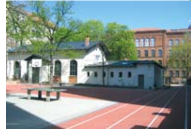
Umgestalteter Schulhof, Turnhalle und hinteres Schulgebäude
