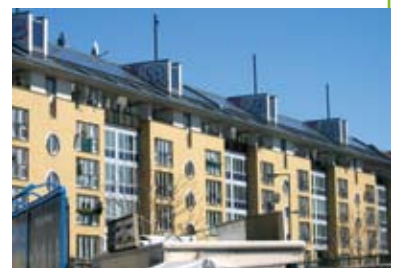
Oranienstr. 57 bis 47: Dienstleistungs- zentrum mit Photovoltaikanlage
