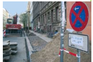
Christinenstraße 28: Erneuerung des Straßen- und Gehwegbelags
