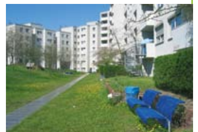
Stallschreiberstraße 8 bis 12: Umgestaltung im Block 611
