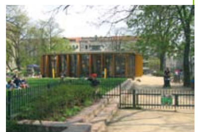
Helmholtzplatz: ehemaliges Trafoshaus umgebaut zum Kiez-Treff
