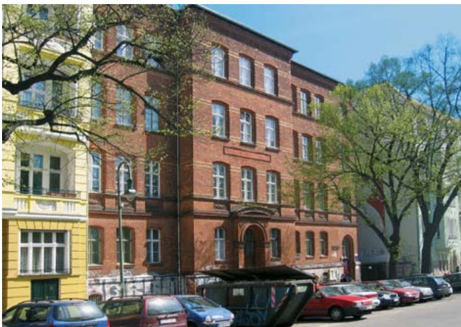
Heinrich-Roller-Straße 18: ökologische Erneuerung der 2. Grundschule
